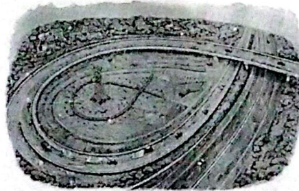
Gambar 2. Kondisi Jalan Saat Hujan
